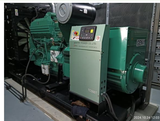
รูปที่ 2.4-13 เครื่องกำเนิดไฟฟ้าสำรอง
