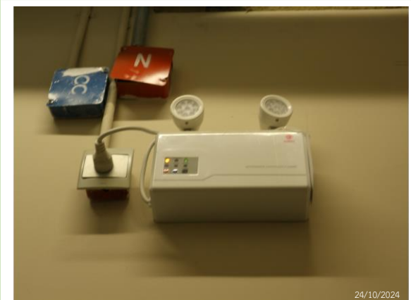
รูปที่ 2.4-14 ไฟส่องสว่างฉุกเฉิน
