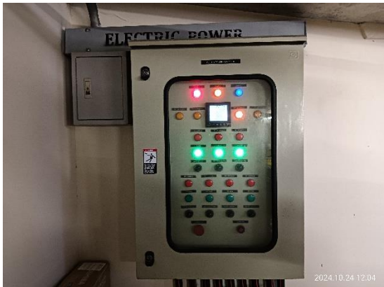
รูปที่ 3-45 มิเตอร์ไฟฟ้าของระบบบำบัดน้ำเสีย
